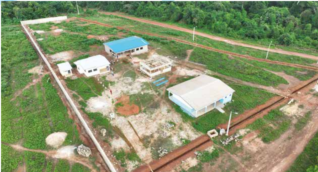
Une vue aérienne du CSR de Daouakro en cours d'extension
