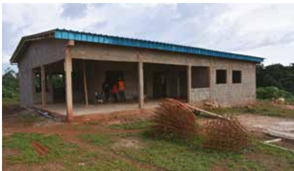
Une vue de la maternité du CSR en cours de construction
