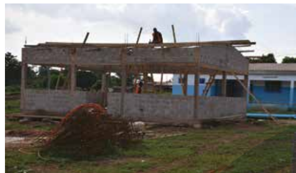
Une vue du préau du CSR en cours de construction
