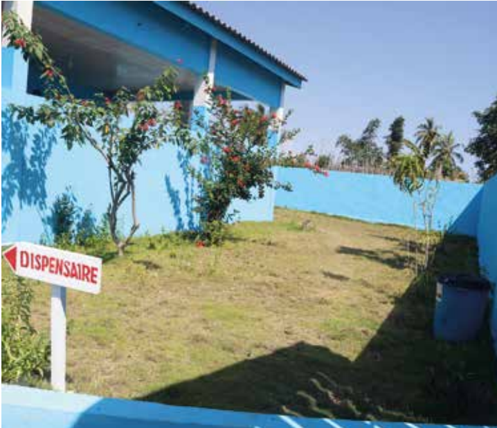
Aménagement de la cour du Centre de Santé intégré d'Assinie-France
