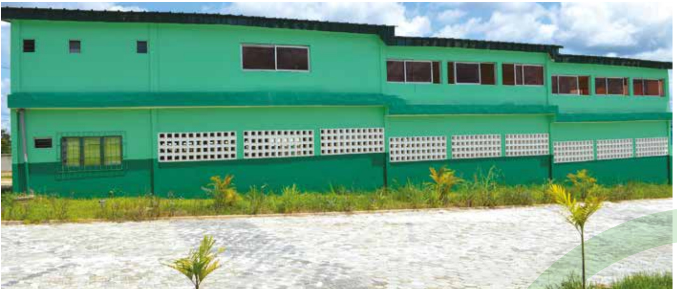
Aménagement de la cour du lycée vert de Godiabrè (Gagnoa)
