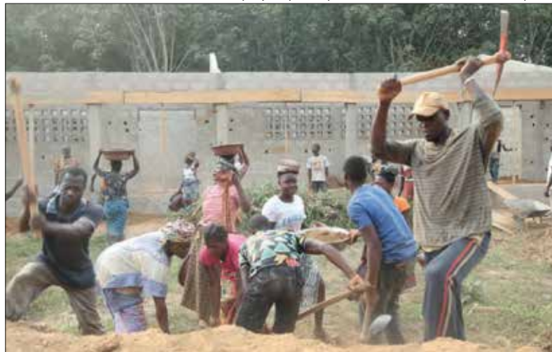
Les habitants de N'Guessan Kouassikro travaillent avec acharnement à la réalisation de l'école primaire du village.
