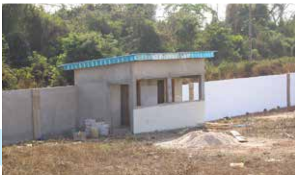
Une vue du bloc toilettes du CSR en cours de construction
