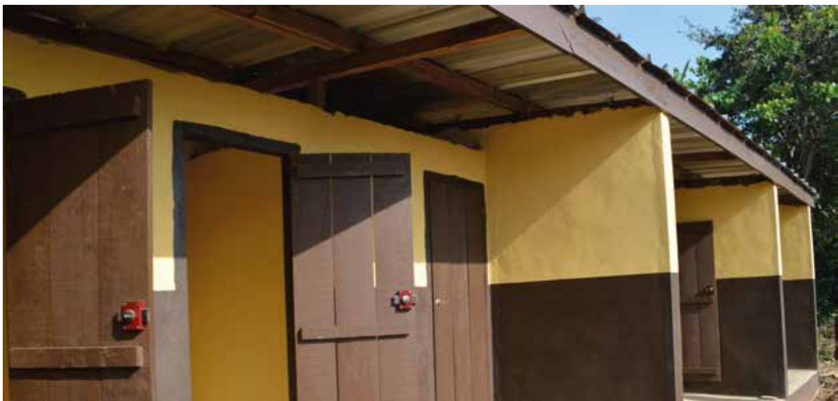
Une vue des toilettes construites
