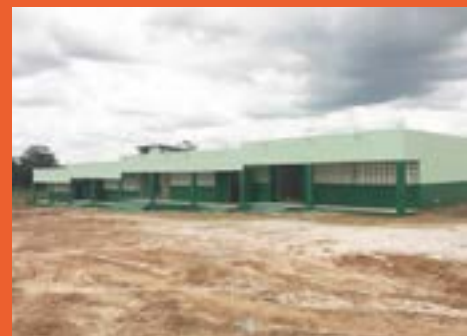
Construction du lycée vert de Gagnoa (1re phase).
