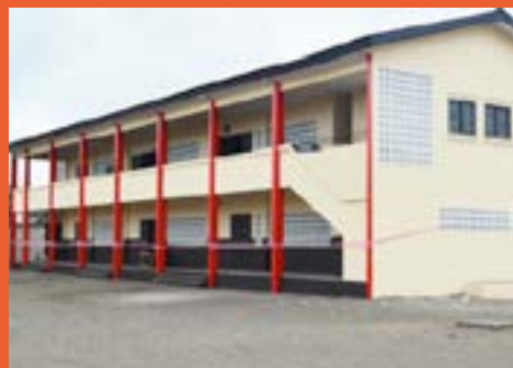
Réhabilitation de l'EPP Aliodan BAD.
