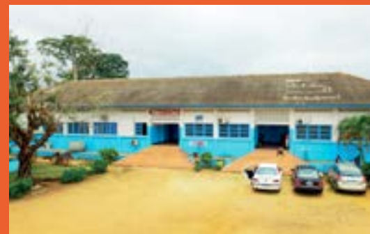
Réhabilitation de la maternité de l'hôpital général de Bingerville.
