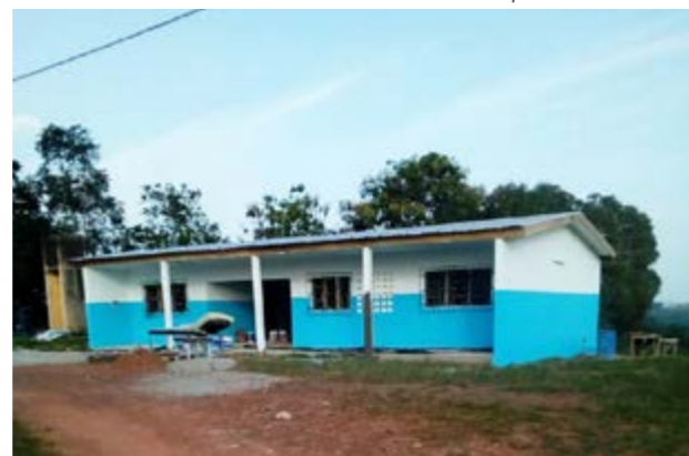
L'infirmerie après réhabilitation
