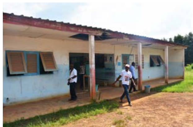
L'infirmerie avant réhabilitation
