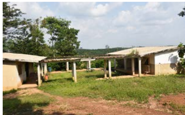
La maternité avant réhabilitation
