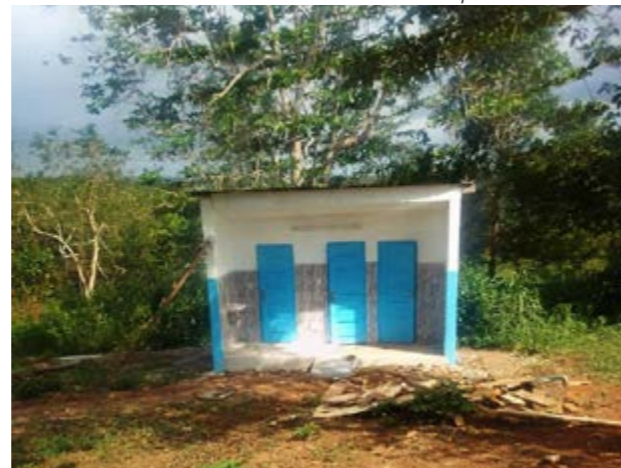
Les toilettes après réhabilitation
