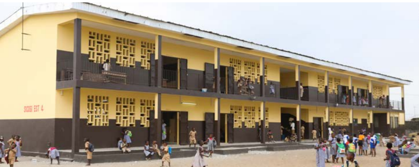
Un bâtiment du groupe scolaire SICOGI EST rénové
