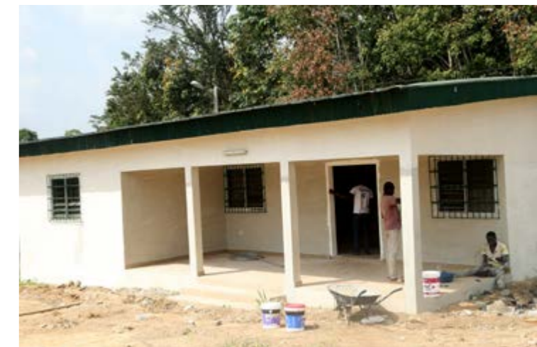
Un logement du principal
