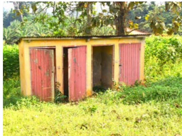
Les toilettes avant réhabilitation
