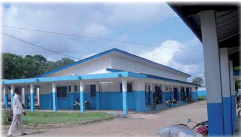
Maternité réhabilitée de l'hôpital Général de Guibéroua
