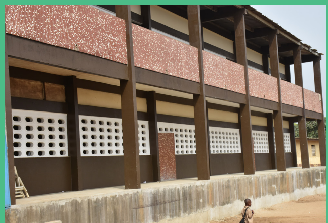
Bâtiment en réhabilitation Epp Gbégbouto d'Attécoubé
