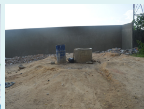
Construction d'un puits au Groupe Scolaire Anoumabo de Marcory.
