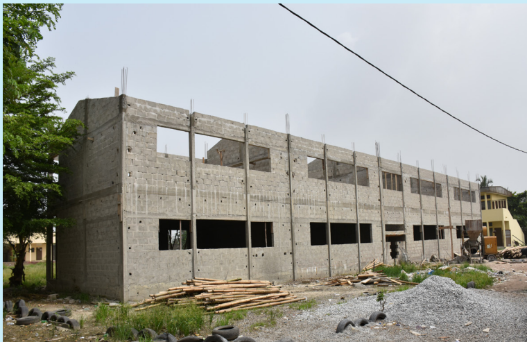
Bâtiment r+1 en construction au Lycée Municipal de Koumassi
