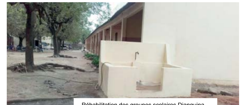
Réhabilitation des groupes scolaires Dianguina Coulibaly et Fadjiguila à Bamako au Mali
