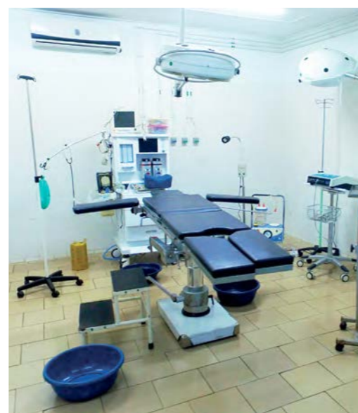
Réhabilitation du bloc opératoire de la maternité de l'hôpital général de Bingerville par la FATOM
