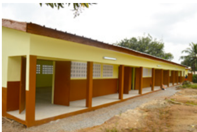
Le bâtiment de 03 salles de classe
