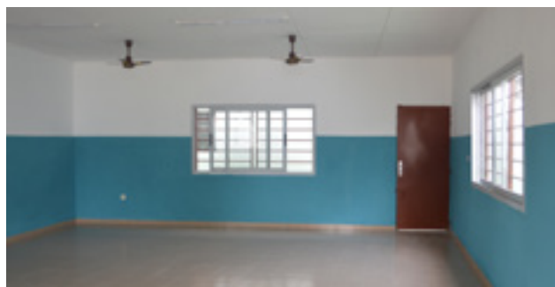
Une vue de l'intérieur de la salle de classe réhabilitée
