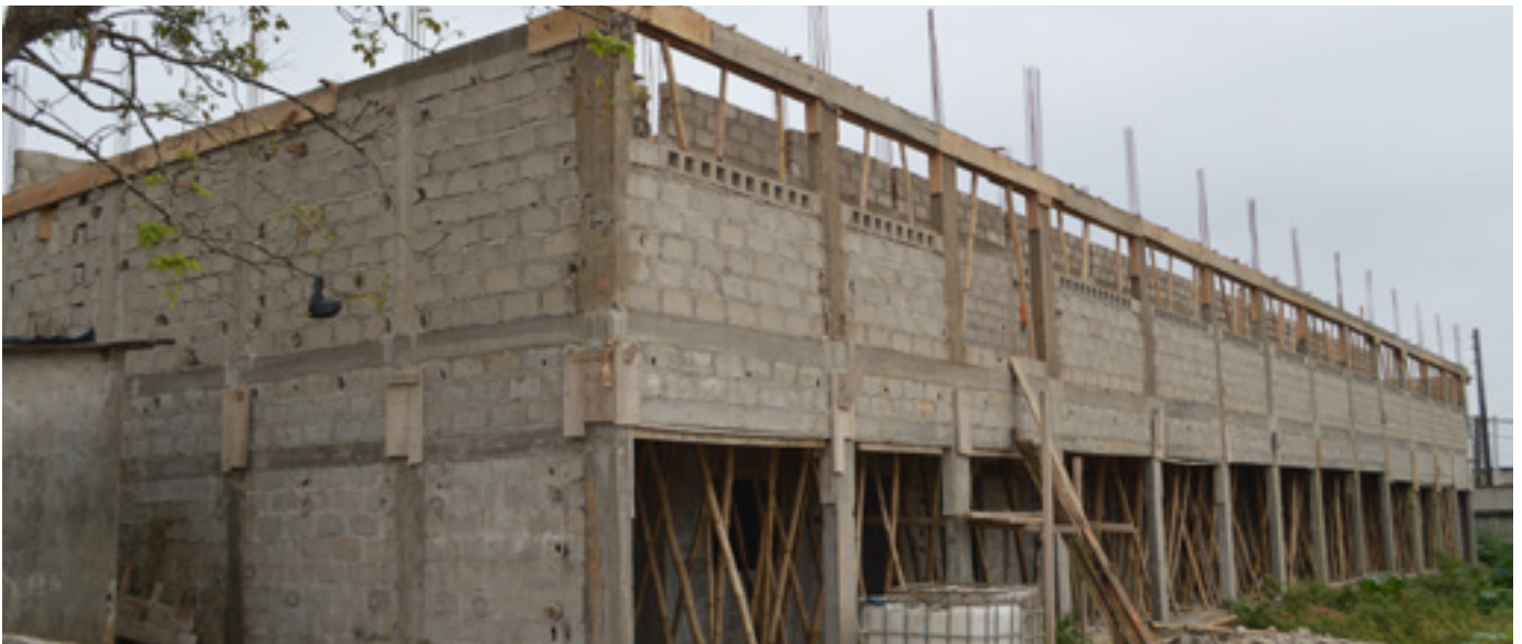
Le bâtiment R+1 en cours de construction
