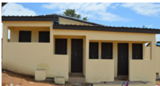
Une vue du bloc toilettes externe
