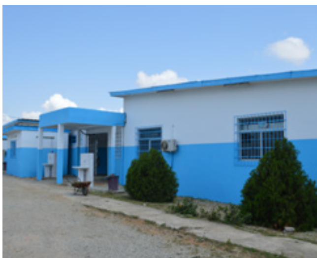
Une vue des bâtiments rénovés
