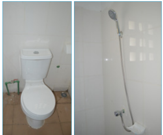
L'intérieur du bloc toilettes
